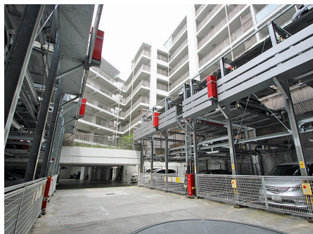
機械式駐車場
