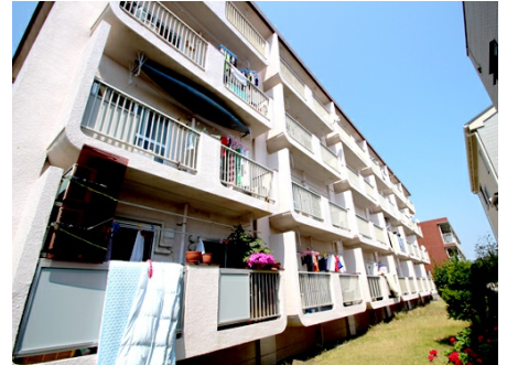
ベランダ方向の外観
