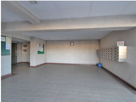
エントランス内部
