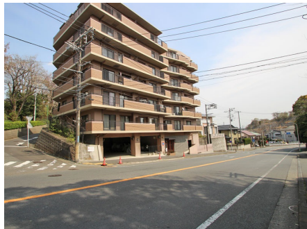
外観と前面道路
