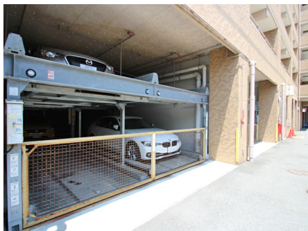
機械式駐車場
