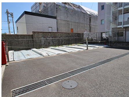
機械式駐車場
