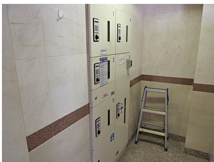
宅配ボックス
