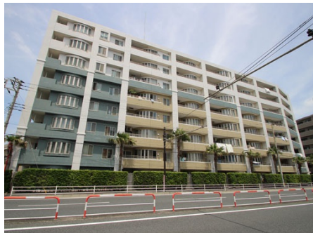
マンション外観2
