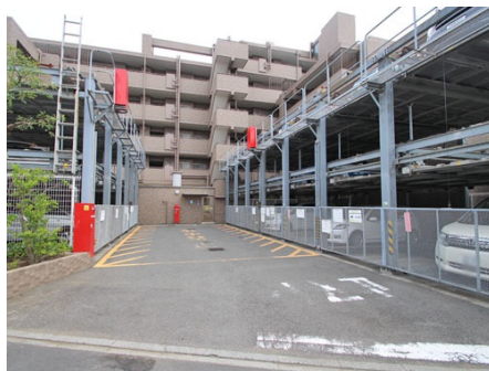
機械式駐車場
