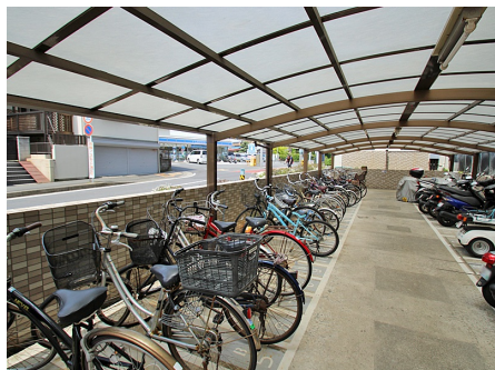
敷地内駐輪場（屋根付）
