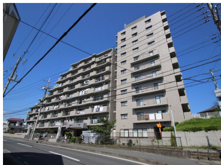
外観と前面道路
