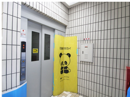
エレベーター
