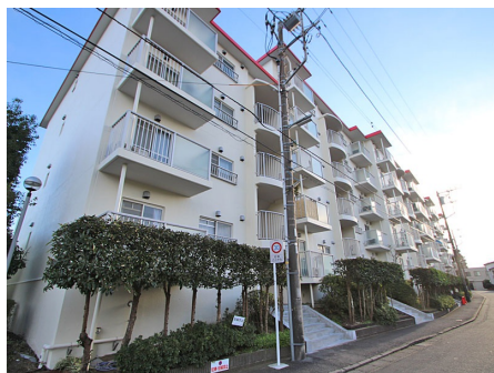
マンション外観(1号棟)
