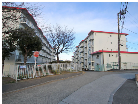
マンション全景
