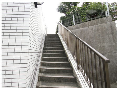
駐車場への入口階段
