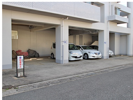
建屋内の駐車場
