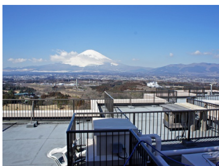
屋上からの景色
