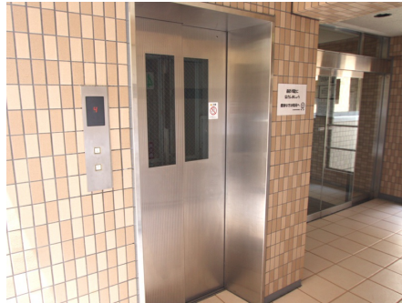
エレベーター
