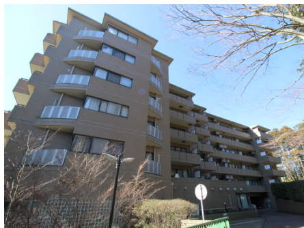
マンション外観 (2番館)
