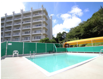
屋外プールより1号棟
