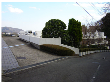
屋上駐車場入口
