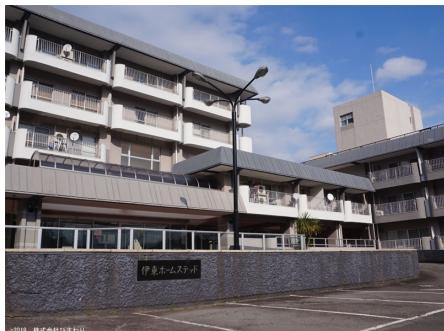
車寄せのあるマンション外観
