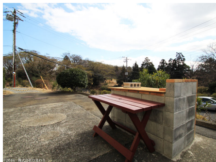
バーベキューコーナー設置
