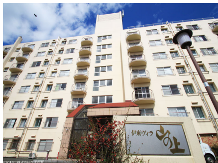
南側からの全景
