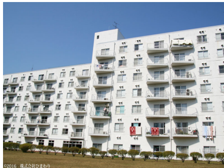
外観エントランス周辺
