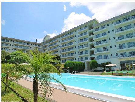
プールから見る一碧苑マンション
