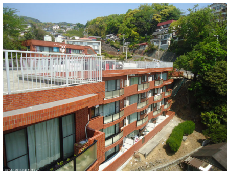
ロワジール伊東湯川
