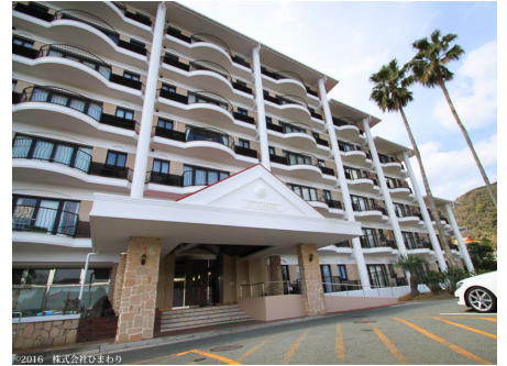
エントランス部
