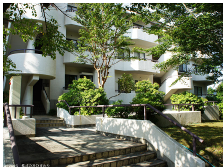
スカイヒルズ C棟
