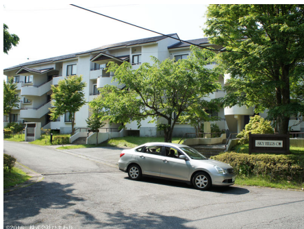
スカイヒルズ C棟
