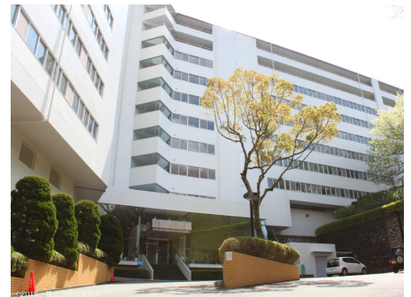
正面玄関付近
