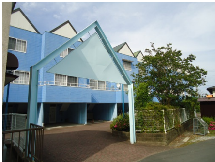
リゾートタウンハウス外観
