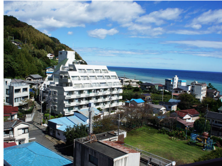
マンション全景
