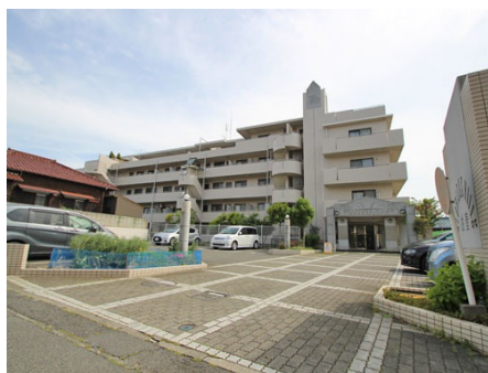
マンション全景
