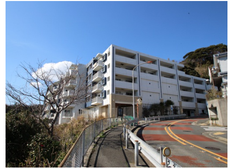
道路側から見た外観
