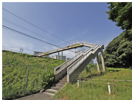
長沢駅に向かう歩道橋
